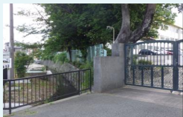
川西北小学校東側(正門付近)の水路
