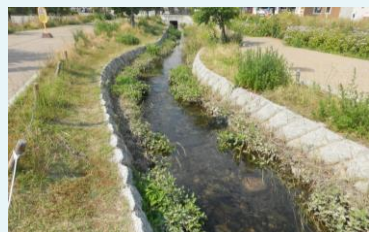
キセラ川西せせらぎ公園の水路
