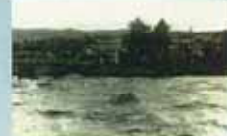
昭和43年8月災害 （多田神社付近）
